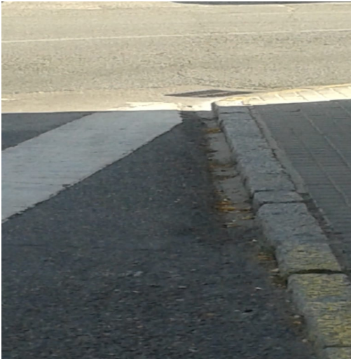
Detalle acceso paso de peatones
